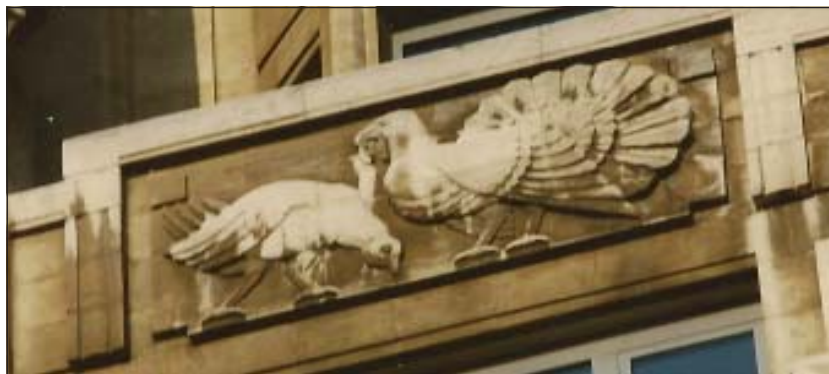
Afb. 2 Detail van de gevel van de 'Boerentoren' (foto R.Paeshuys)
